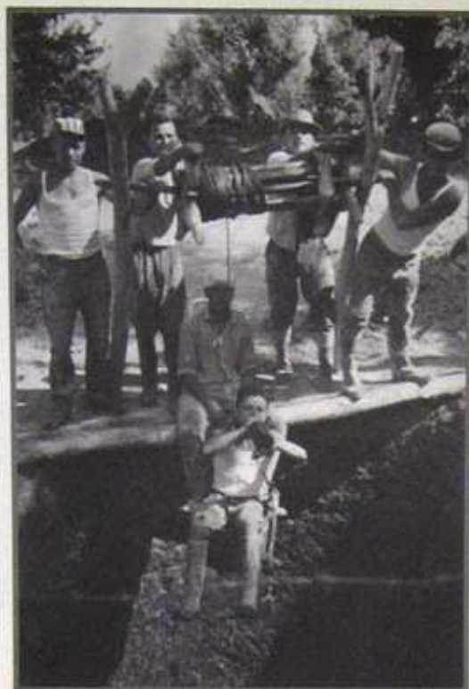
Escavazione di un pozzo
