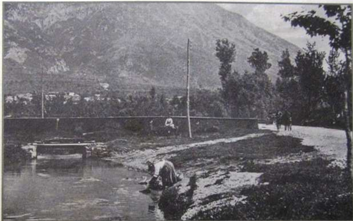
Fiume Isclero (ponte Parata) - Bucciano
