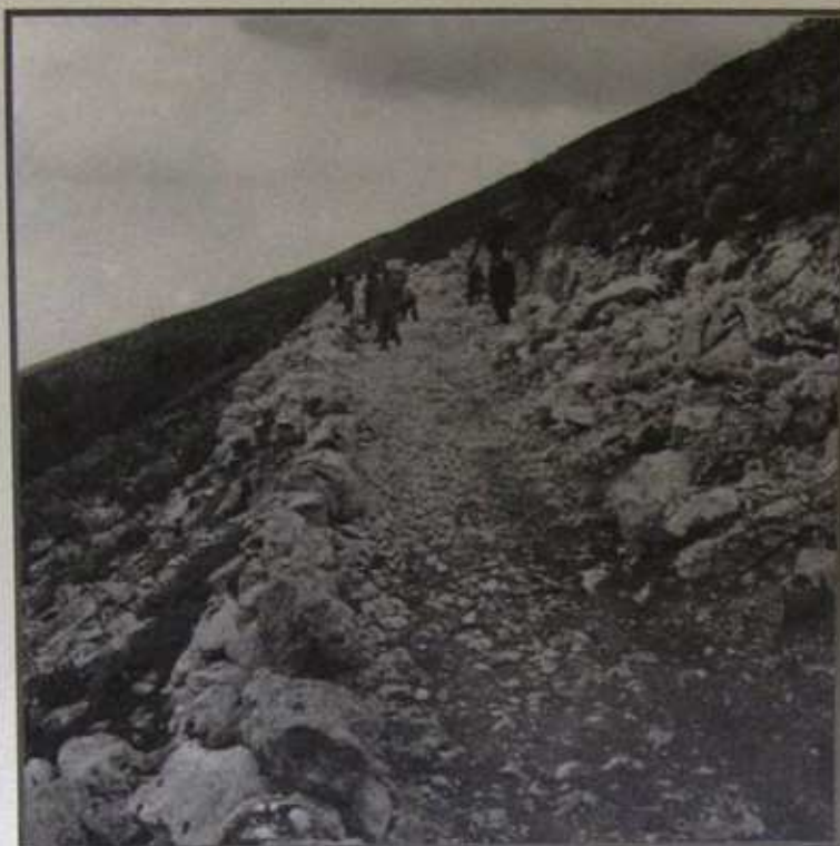
Costruzione della strada di collegamento al Santuario del monte Taberna
